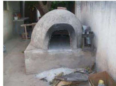
Foto 39. Horno de barro, recubierto con cemento. (Esc. N° 30-Choya)
