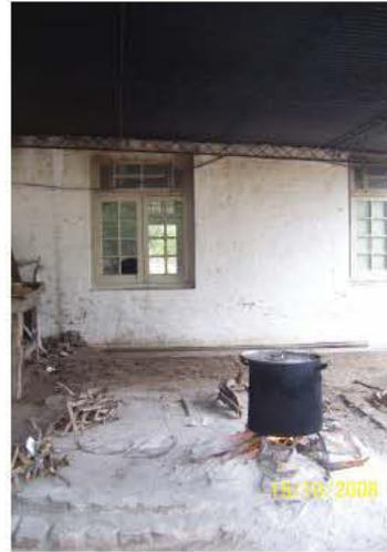
Foto 29. Fogón, sobre piso de ladrillos (antigua base del horno de barro). Techo tiznado. Detrás, ventana de un aula. (Esc. N° 1073-Ancaíán)
